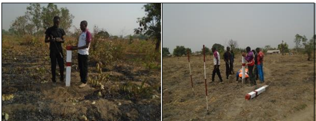
Photo 34: Levée topographique et bornage du site de Kpéhoun
